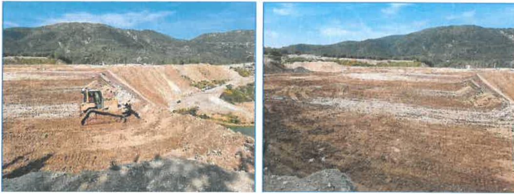
Déblaiement des tas d'inertes vers talus – trainées de régalinge des tas d'inertes sur la plateforme (avant poussage)
