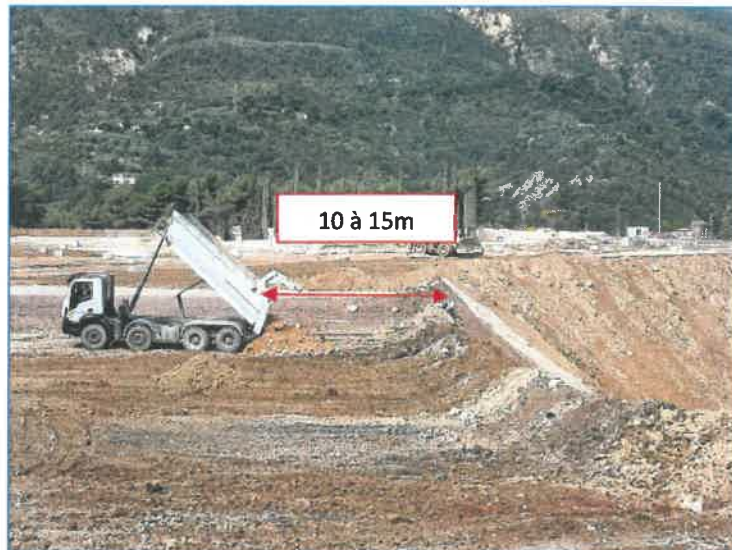
Déchargement à distance sécuritaire
